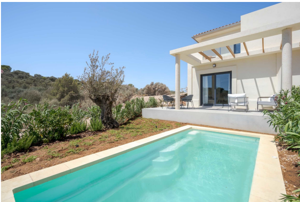
Piscina (Casa piloto)
